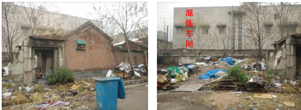
部分未拆除的建筑物现状
